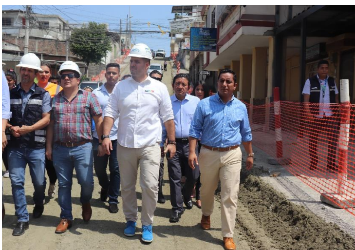
Fotografía 17: Fiscalización de obra en la calle 297
