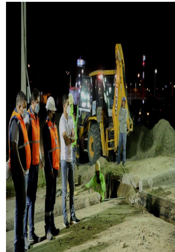
Fiscalización (instalación de tubería vía puerto-aeropuerto)
