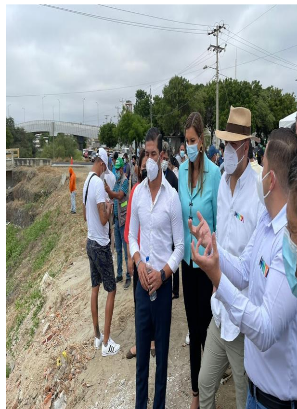
Fiscalización evento De construcción del sistema de bombeo y tuberías estación la Roca (EPAM)
