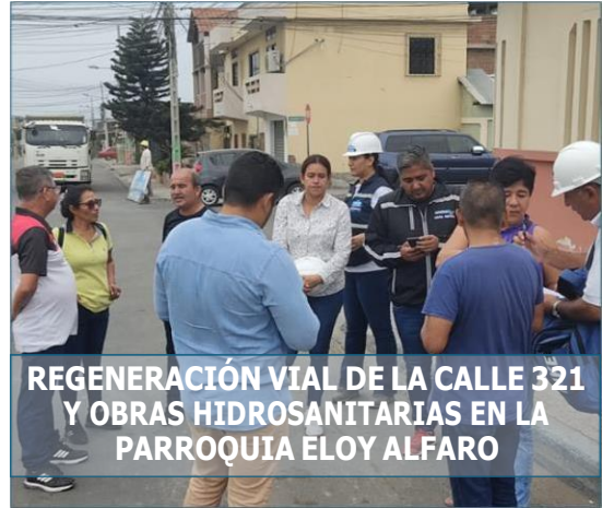
REGENERACIÓN VIAL DE LA CALLE 321 Y OBRAS HIDROSANITARIAS EN LA PARROQUIA ELOY ALFARO
