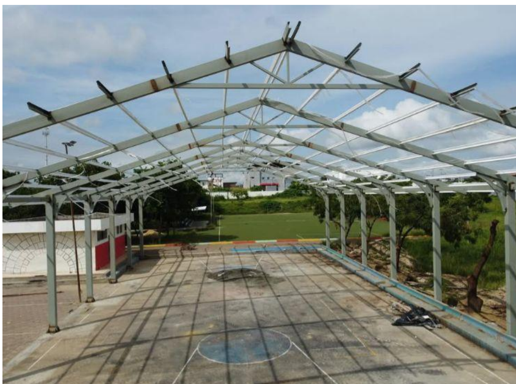
Colocación de Cubierta Colegio Réplica Manta
