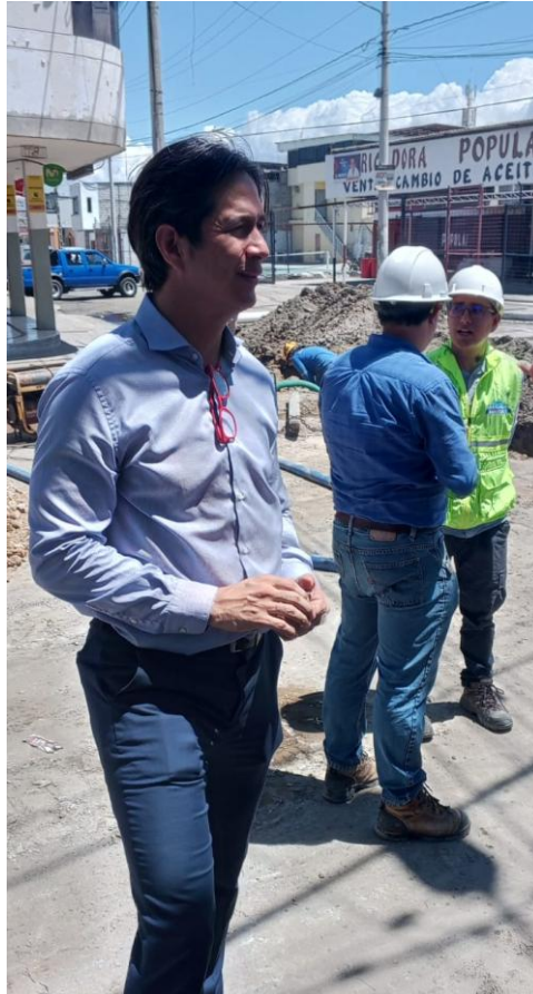
Inspección Obras en la Avenida 105
