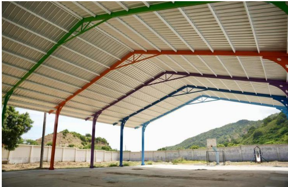
Colocación de cubiertas Colegios de Santa Marianita
