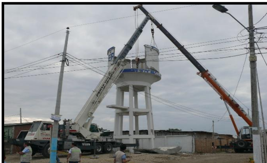
Imagen 1. Derrocamiento de reservas posterior al terremoto de 2016
