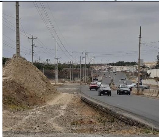
Fotografía 6 Tramo 3 entre puentes elevados de Avda. Spondylus
