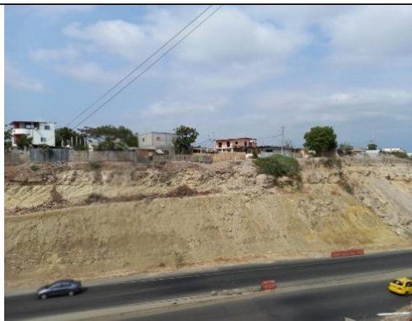
Fotografía 28 Tramo 15 desestabilización talud sobre vía Spondylus entre urbanización Sarilam y calle 293 conexión a Cumbres 2
