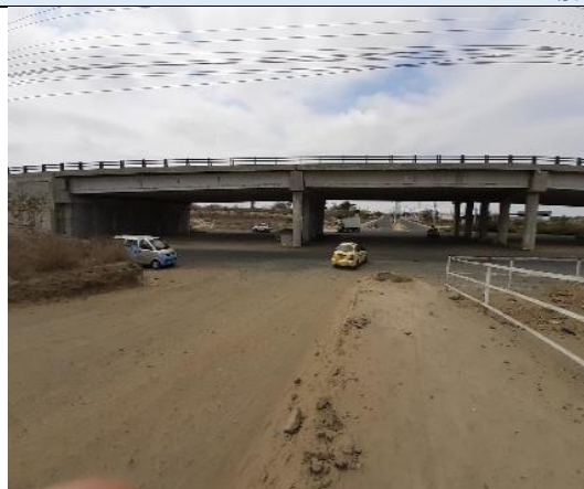
Fotografía 15 Tramo 6 interconexión a Nva Esperanza y vía Francisco Robles.
