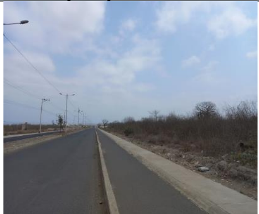
Fotografía 7 Tramo 4 pavimentado Avda. Francisco Robles ciclo ruta lado izquierdo.
