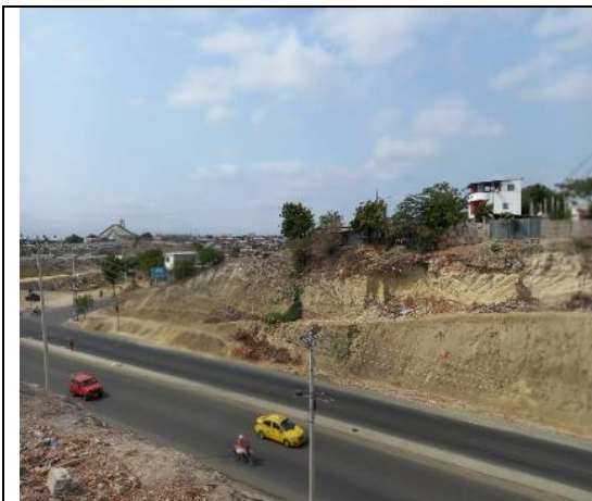
Fotografía 28 Tramo 15 desestabilización talud sobre vía Spondylus entre urbanización Sarilam y calle 293 conexión a Cumbres 2
