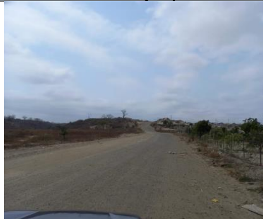
Fotografía 8 Tramo 4 en tierra Avda. Francisco Robles acceso a futura Planta Manta.
