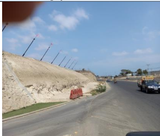
Fotografía 5 Tramo 2 entre Avda. Spondylus y primer puente elevado.
