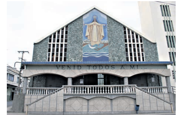
Imagen 023: Fachada de la iglesia La Merced
