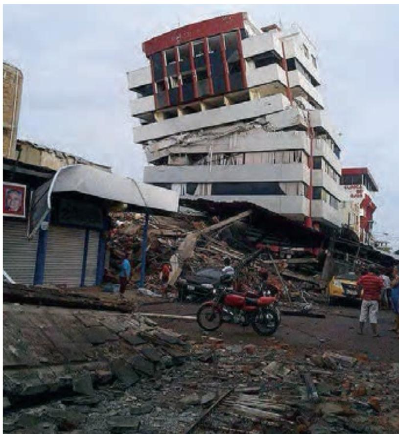
Figura 163: **Colapso total de la estructura. Portoviejo, Ecuador 2016.**
