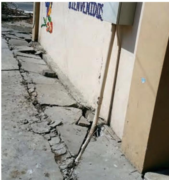
Figura 165: **Cimentación afectada por problemas geotécnicos. Manta, Ecuador 2016.**
