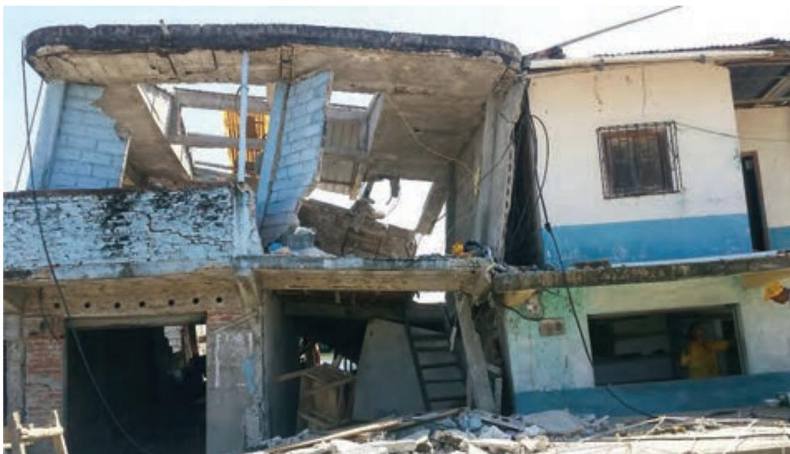
Figura 169: **Edificación fuera de aplomo. Terremoto de Pedernales, Ecuador 2016.**
