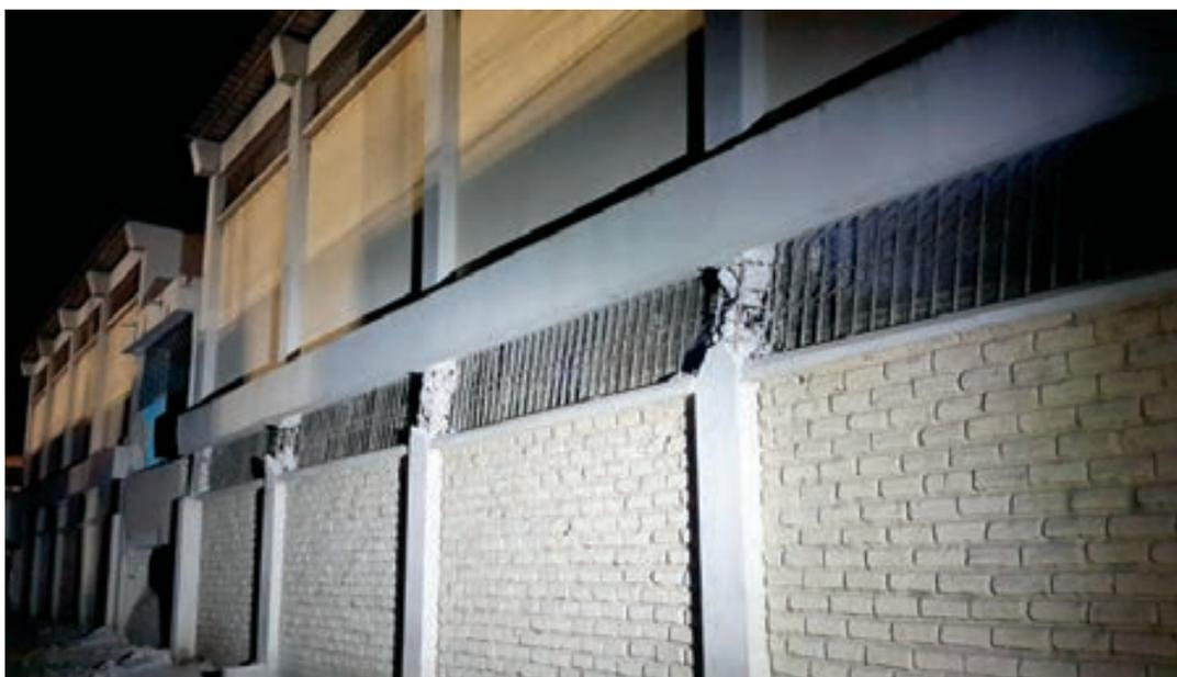
Figura 173: **Daños severos en columna, explosión del hormigón. Terremoto de Pedernales, Ecuador 2016.**
