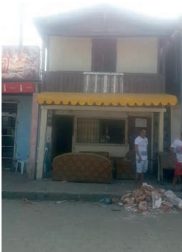
Figura 170: **Edificación fuera de aplomo. Terremoto de Pedernales, Ecuador 2016.**
