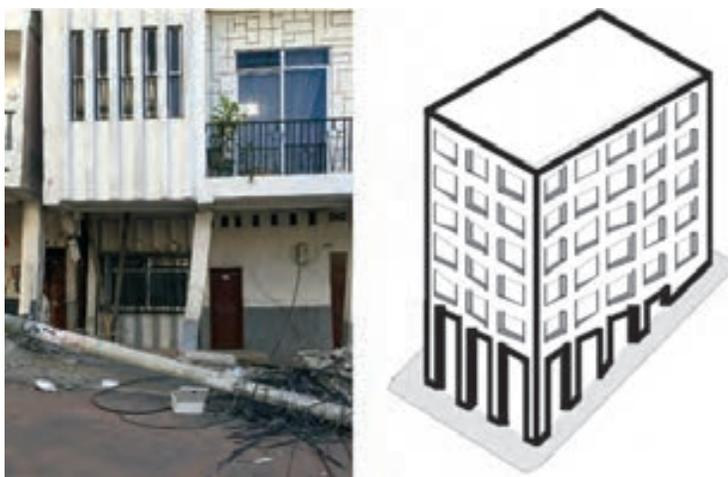
Figura 21: **Columnas cortas o esbeltas: terreno con inclinación**
