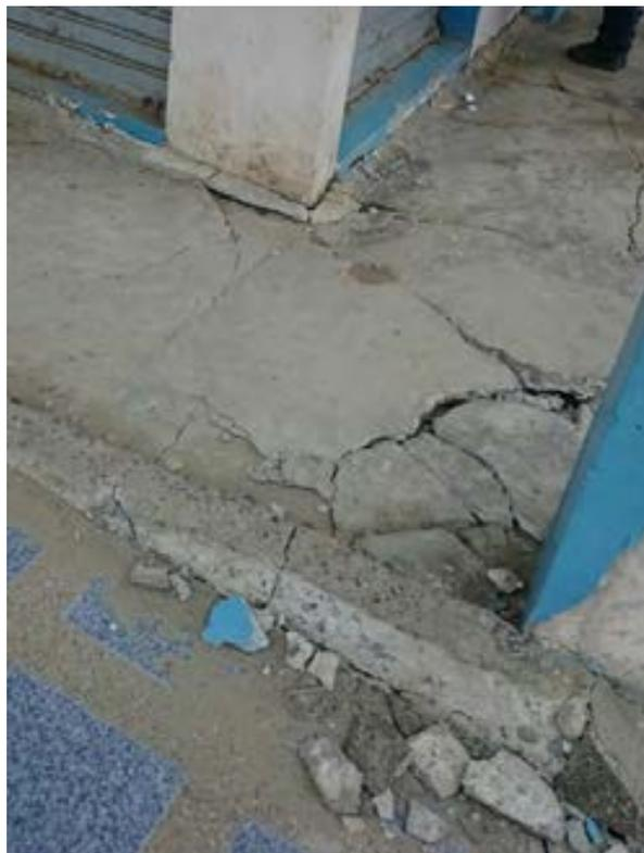
Figura 166: **Hundimiento de cimentación. Muisne, Ecuador 2016.**
